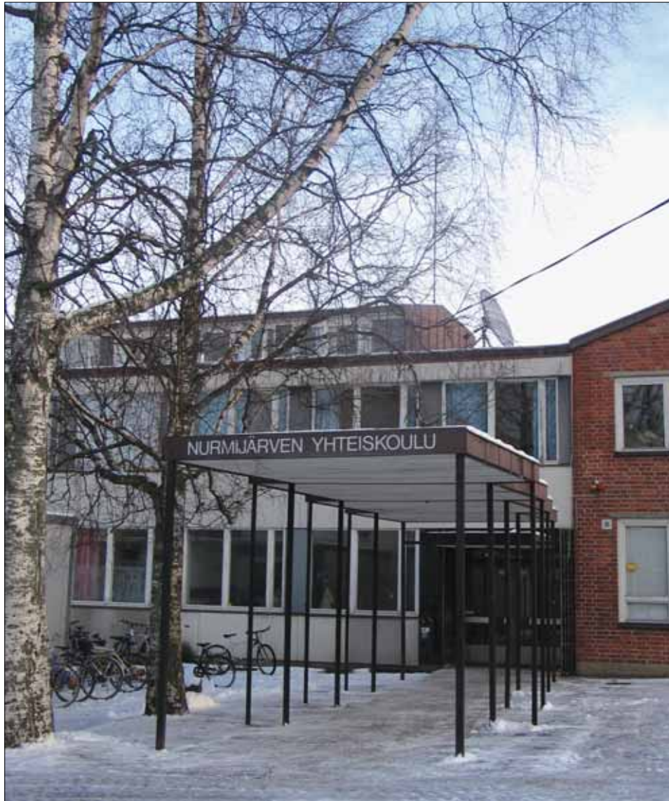
Nurmijärven yhteiskoulun peruskorjaus ja laajennus on 7,4 miljoonan euron hanke.
