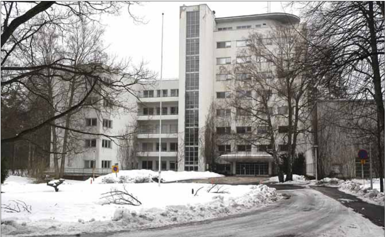
Kiljavan sairaalan remontointi alkaa keväällä.
