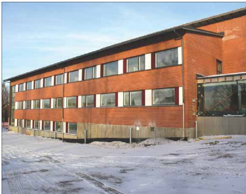
Klaukkalan terveysaseman laajennus on sujunut aikataulussaan. Rakennustyöt valmistuvat maaliskuun lopussa ja tiloja päästään kalustamaan. Uusia tiloja otetaan käyttöön toukokuussa.
